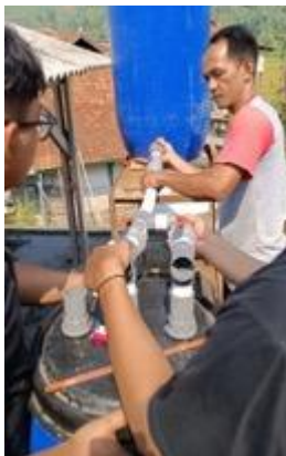
Gambar 10 Pemasangan Alat Dibantu Warga
