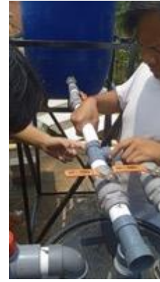
Gambar 13 Penataan Jalur Air dengan Pipa
